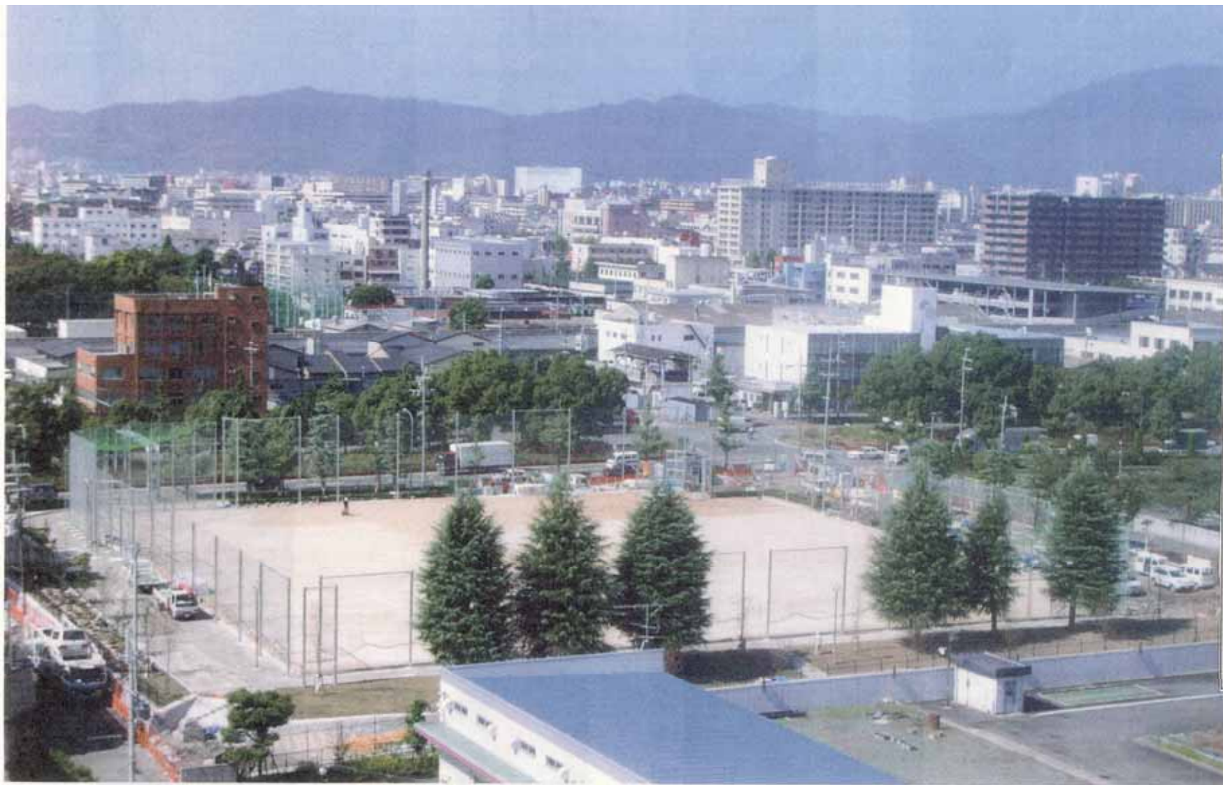
対策・改修後の銚立公園の全景 H18.10
