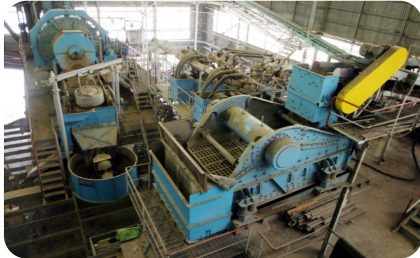
浄化等処理施設（浄化）
