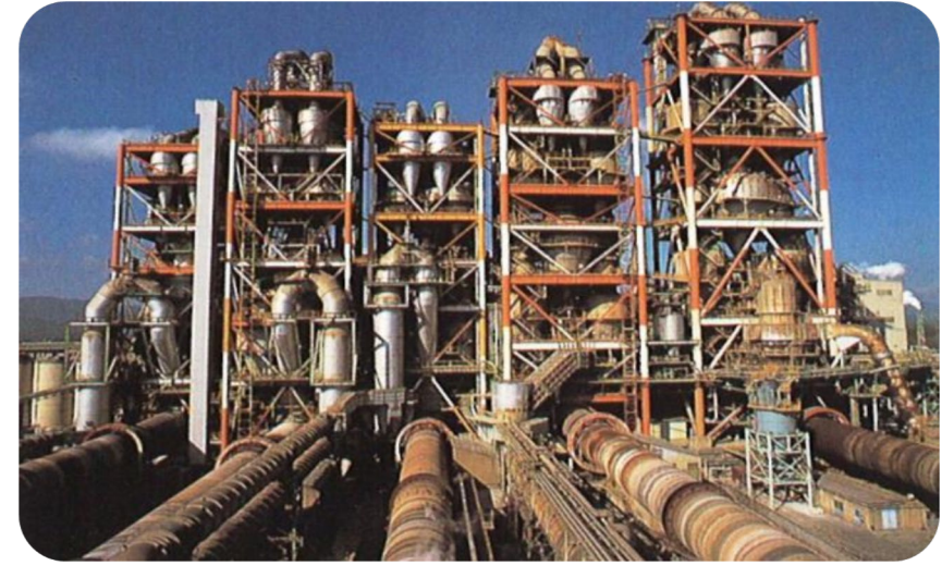
セメント製造施設
