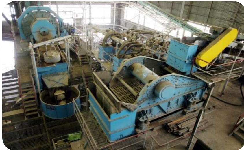
浄化等処理施設（浄化）
