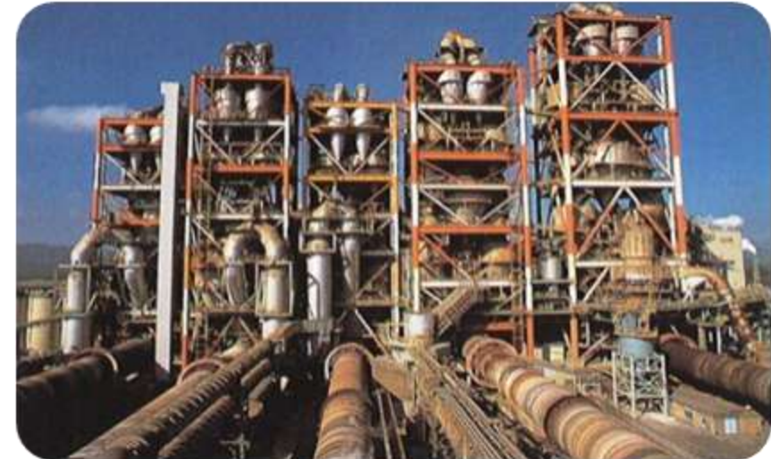
セメント製造施設
