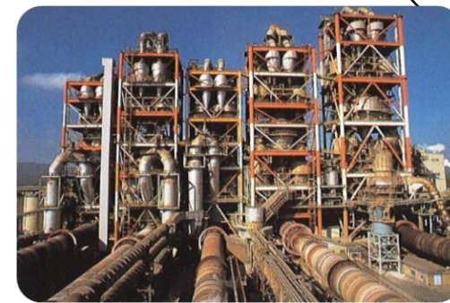
セメント製造施設 (21施設)
