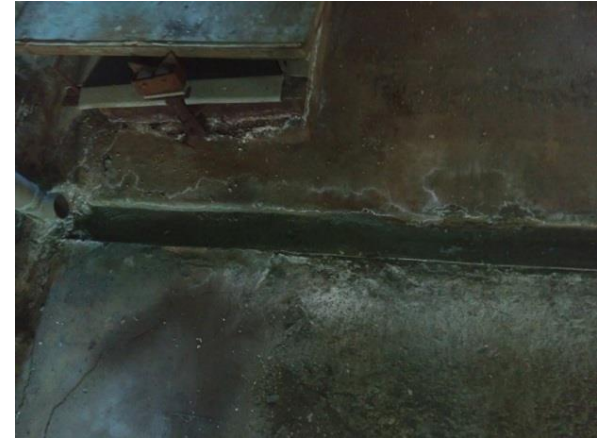
コンクリートやメッキ槽の劣化箇所から土壤へ浸透
