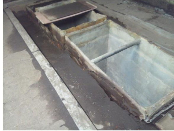
コンクリートやメッキ槽の劣化箇所から土壤へ浸透
