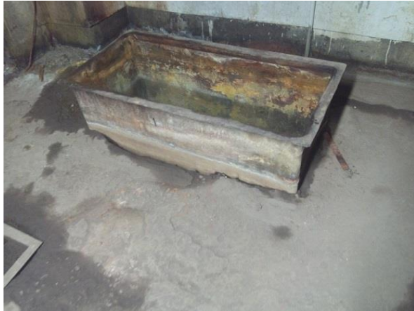
コンクリートやメッキ槽の劣化箇所から土壤へ浸透
