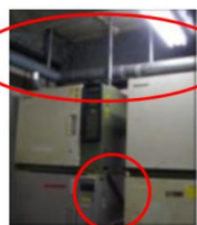
【2段積み恒温器の固定】
