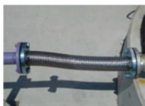
図11 可とう性配管（フレキシブル管）の導入の例
