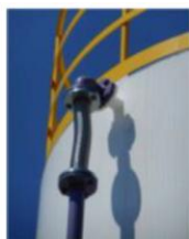
図11 可とう性配管（フレキシブル管）の導入の例
